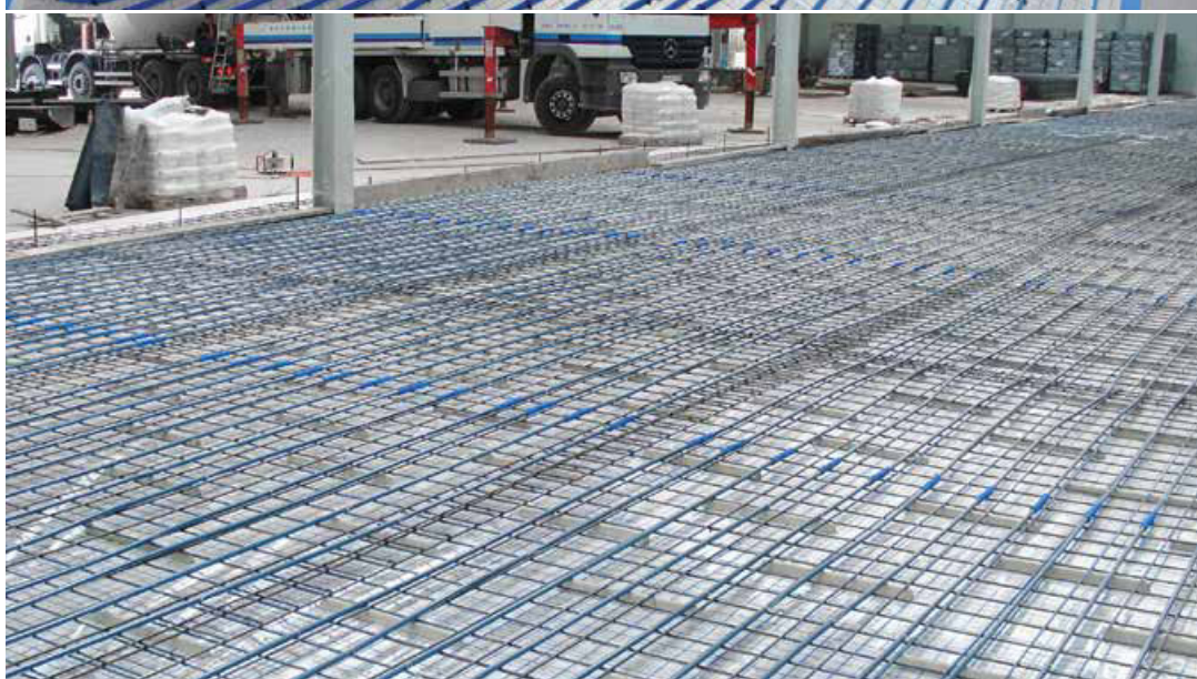
Slika 4. Instalacija podnog grijanja u industrijskom objektu, korištenjem blueFLOOR PERT cijevi i KAN-therm NET sistema.
