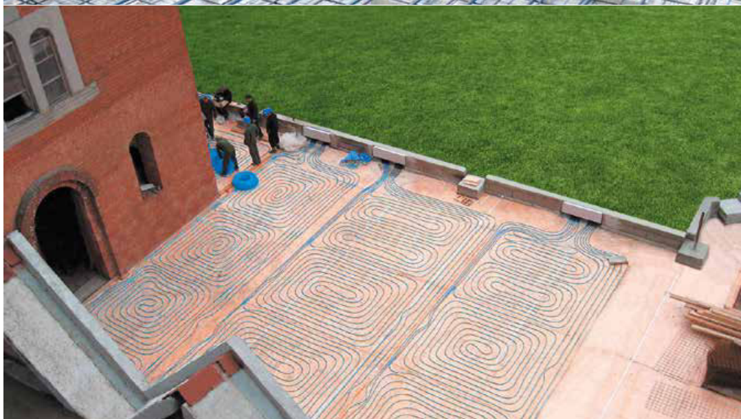
Slika 5. Instalacija grijanja vanjske terase korištenjem blueFLOOR PERT cijevi i KAN-therm sistema.
