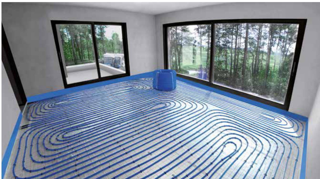
Slika 3. Instalacija podnog grijanja u jednoobiteljskoj zgradi, korištenjem blueFLOOR PERT cijevi i KAN-therm Tacker sistema.
