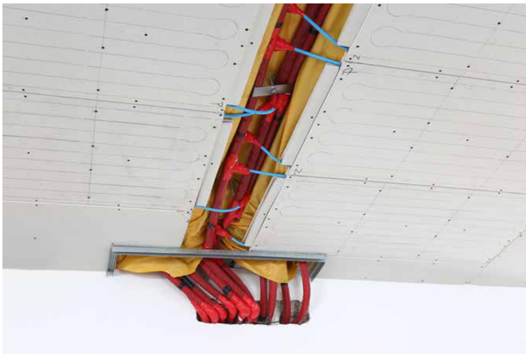
Slika 6. Instalacija stropnog hlađenja pomoću ploča za grijanje i hlađenje KAN-therm Wall sistema.
